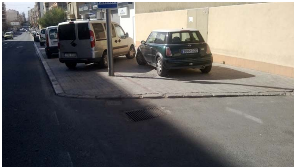
Parte central, hacia La Vila. Acera deteriorada, vehículos invadiendo los recorridos peatonales, inexistencia de rebajes.
