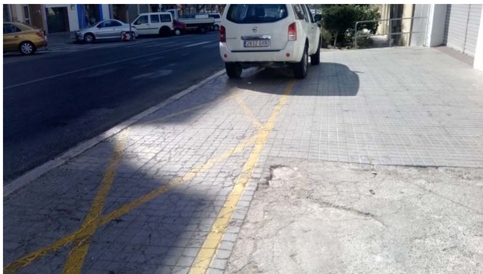
Parte central, hacia La Vila. Acera deteriorada, vehículos invadiendo los recorridos peatonales, inexistencia de rebajes.
