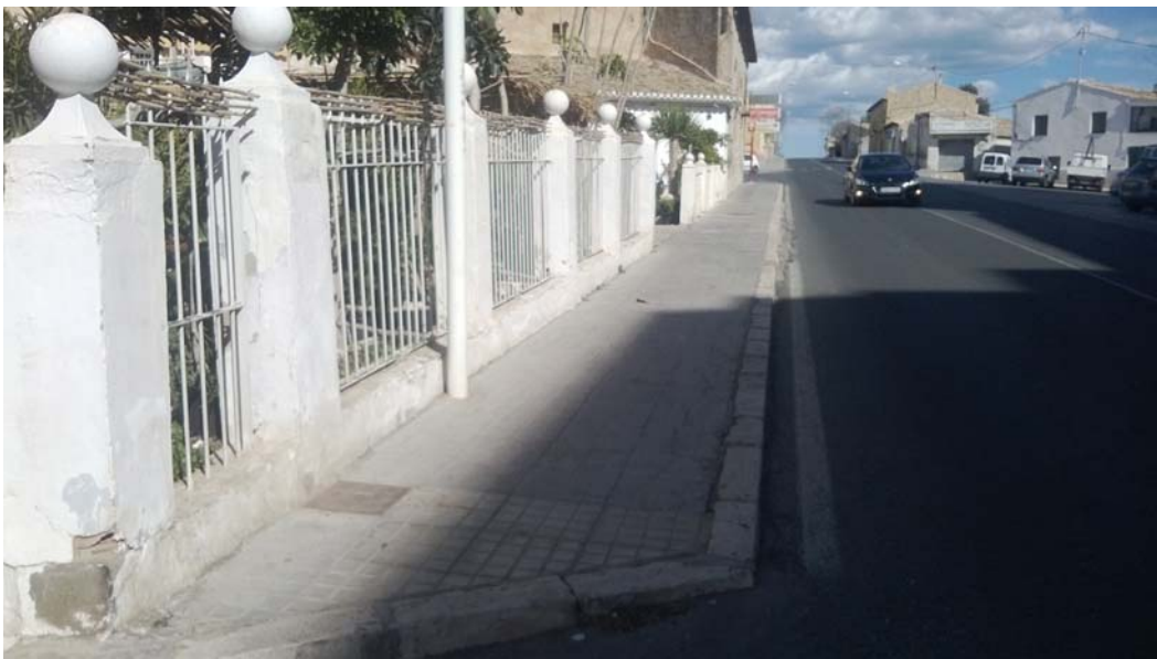
Tramo final hacia Benidorm. Acera deteriorada, de escasa anchura y sin rebajes
