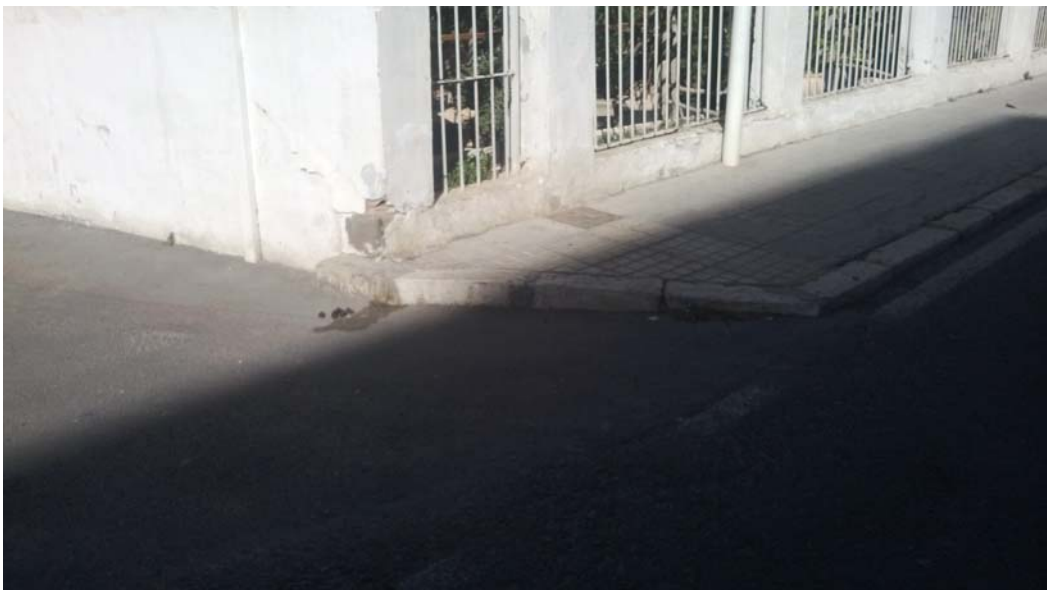
Tramo final hacia Benidorm. Acera deteriorada, de escasa anchura y sin rebajes
